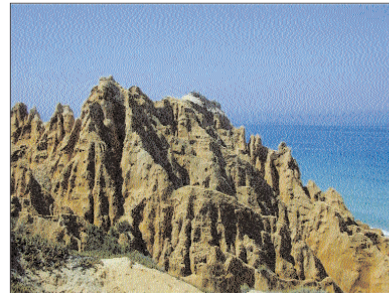
Figura 2 – Erosão subaérea das arribas areníticas na Praia da Galé – Fontainhas
